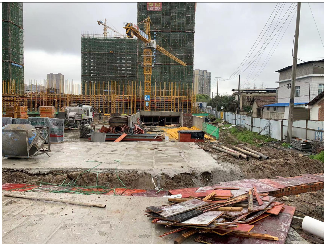
地块施工中照片
