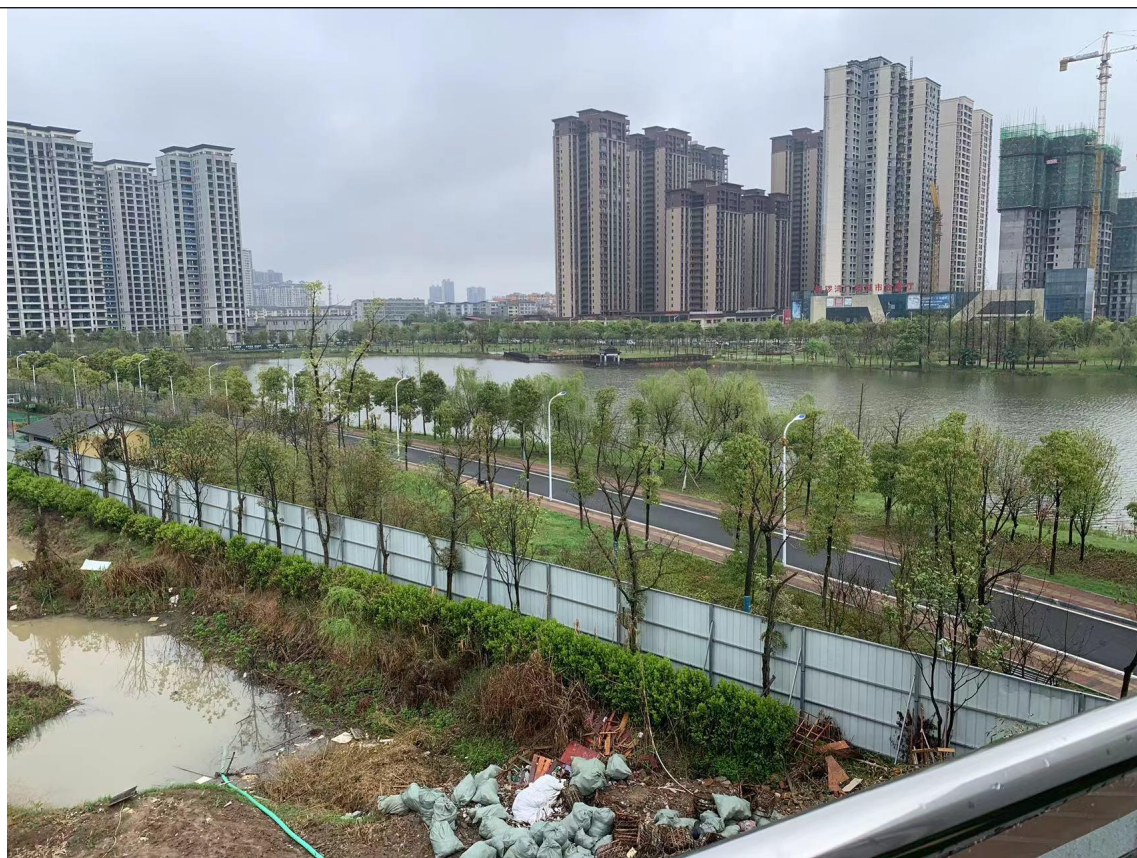
地块施工中照片
