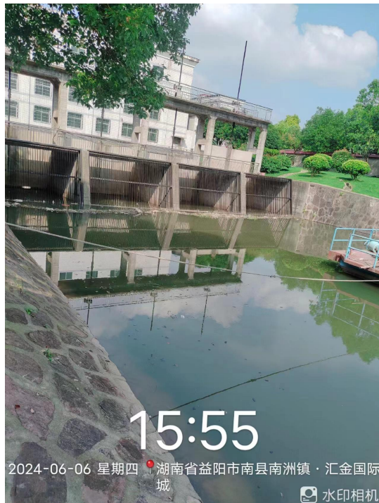
鱼尾洲主干渠东北侧石码头电排(与藕池河东支连接)
