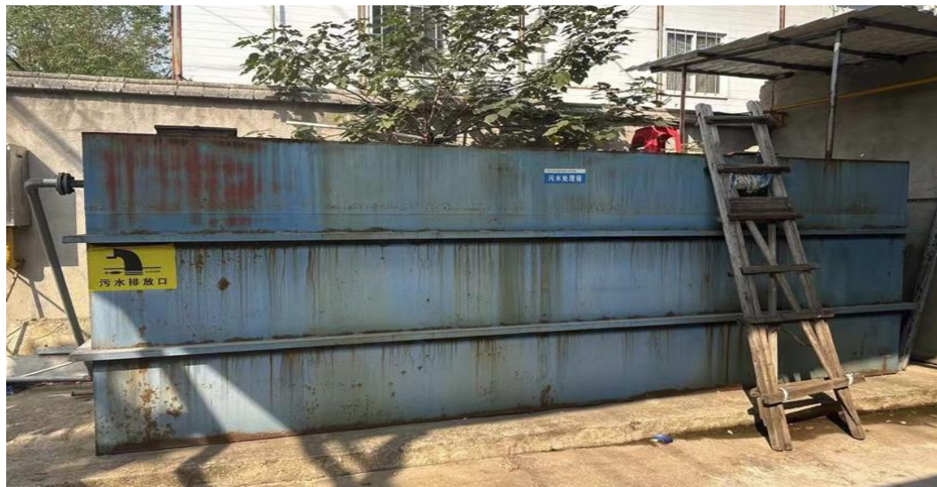
图 2-4 院内现有污水处理站现状图（封闭箱式）
